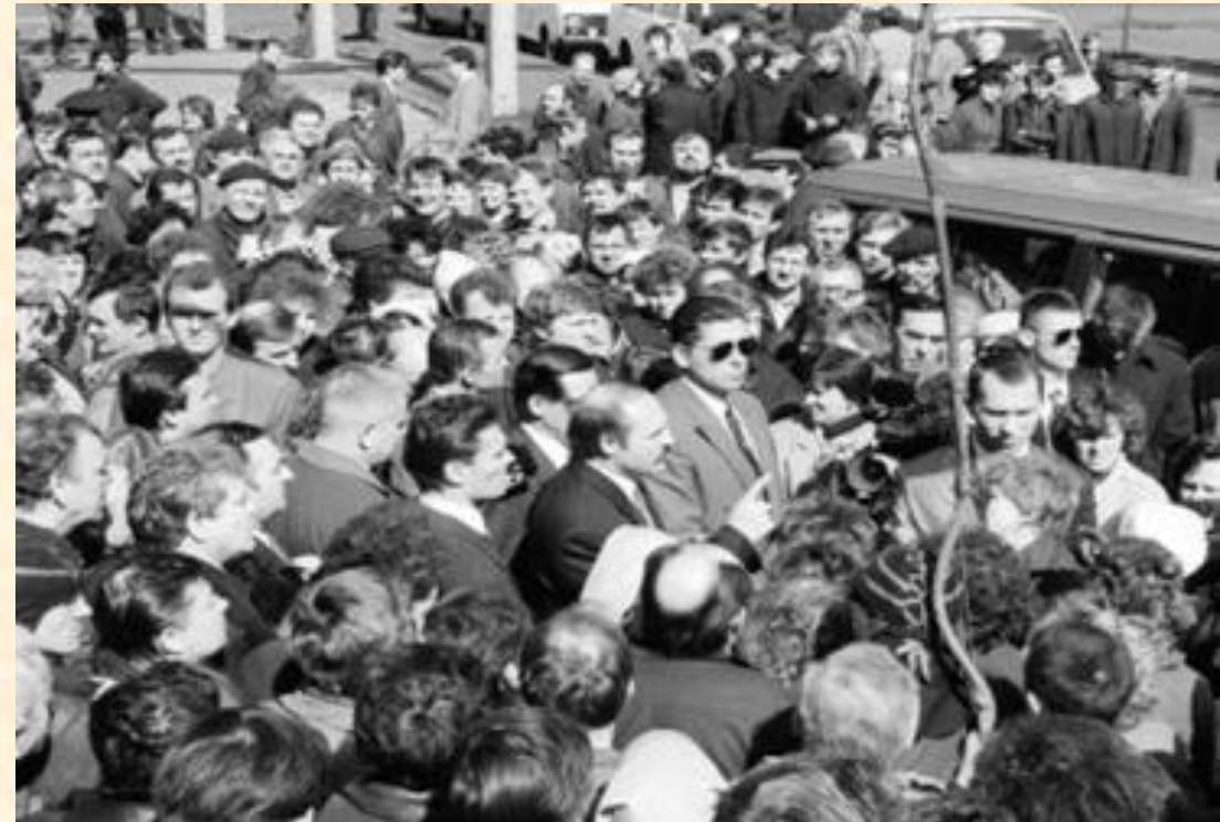
Тракторный завод 19 апреля 1995 г.
